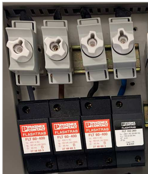
Descargador de sobretensiones
